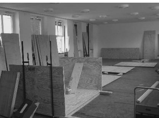
Газибо на Санџо Силва е пПоец на изгПаждане Gazebo by Sancho Silva, construction process
